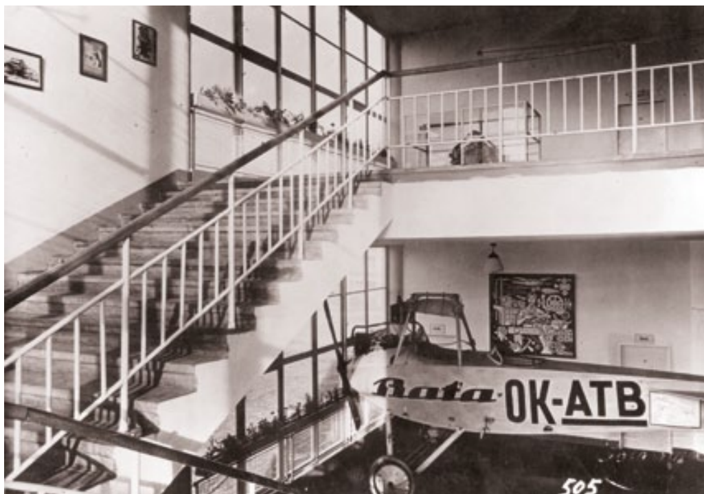
Studijní ústav, schodiště s letadlem firmy Baťa, 1937. Fotoarchiv MJVM. |
